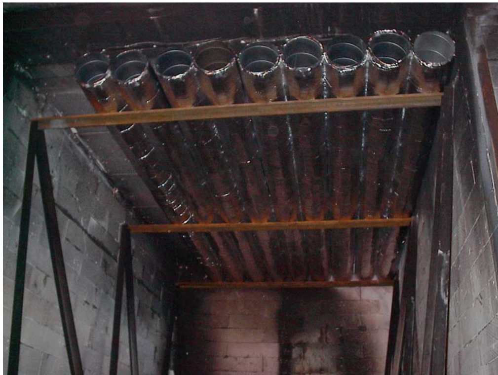
Foto 1 Rørisolasjonen Astro-Foil Reflective Insulation monterert i taket i brannrommet før prøving.
